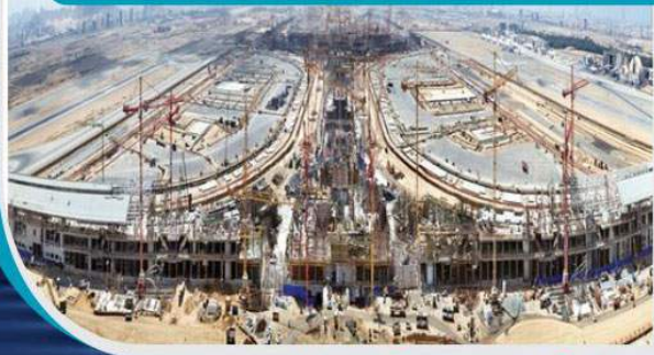
MAINTENANCE HANGER - JEDDAH
